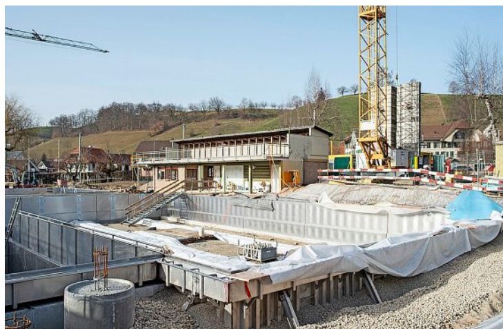
Die Modernisierung der Badi Krummacker – eine Aufnahme von Ende Februar – dauert etwas länger als geplant. Foto: Franziska Rothenbühler
