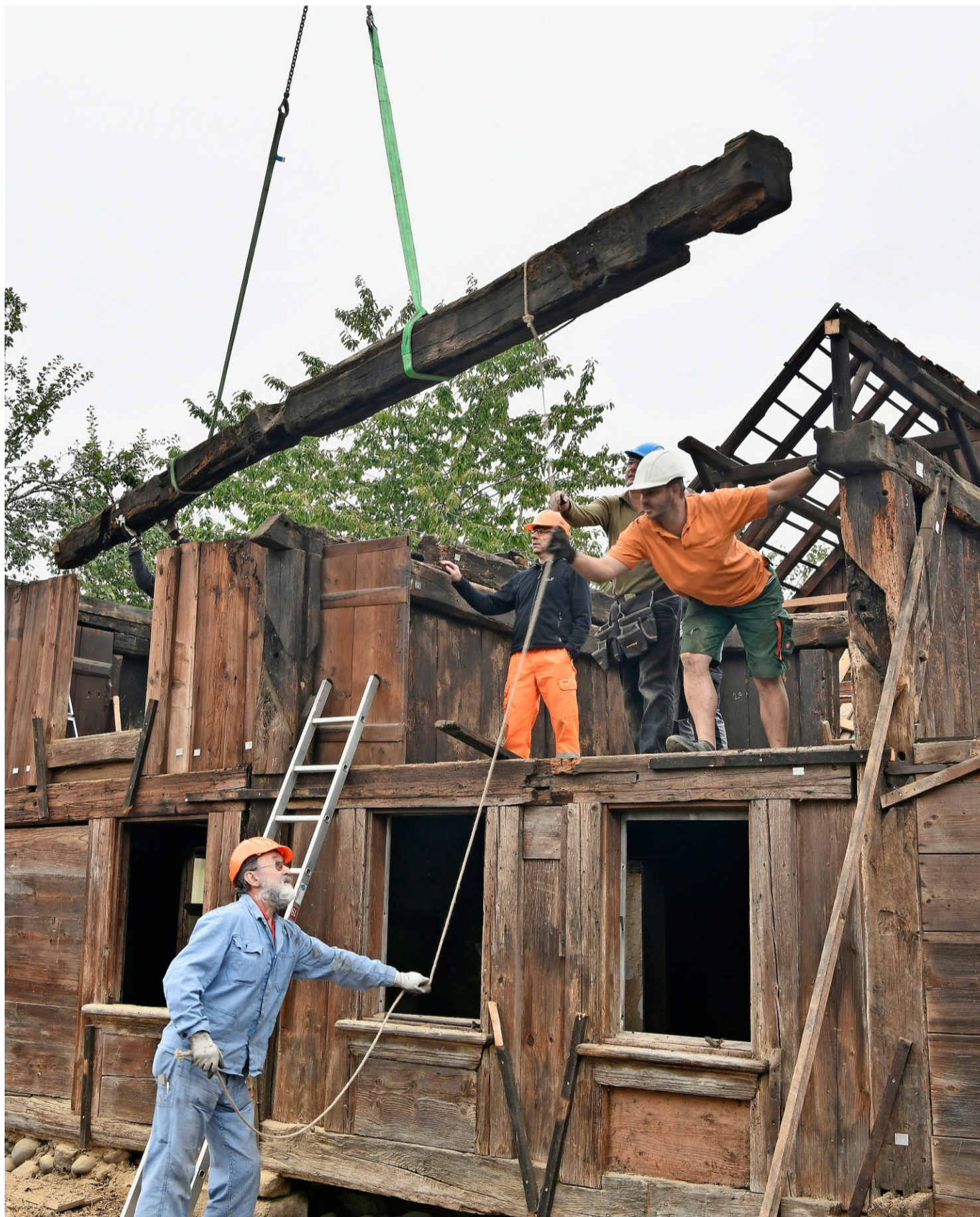
In Thunstetten wird an der Kirchgasse das Holzhaus auf dem Jahr 1480 zurückgebaut. Foto: Thomas Peter
